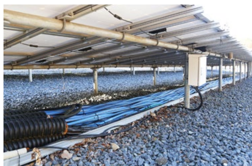
古河電工のアルミ導体ケーブルは被覆が青く一目瞭然だ
